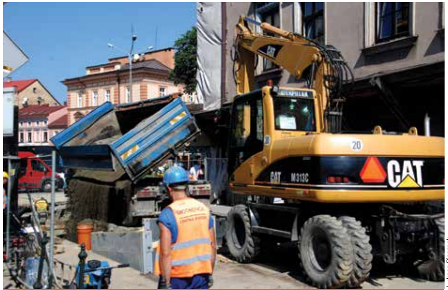
Do 24 września br. w ramach projektu wybudowano już ponad 82 tysiące metrów nowych kanałów sanitarnych i deszczowych.
